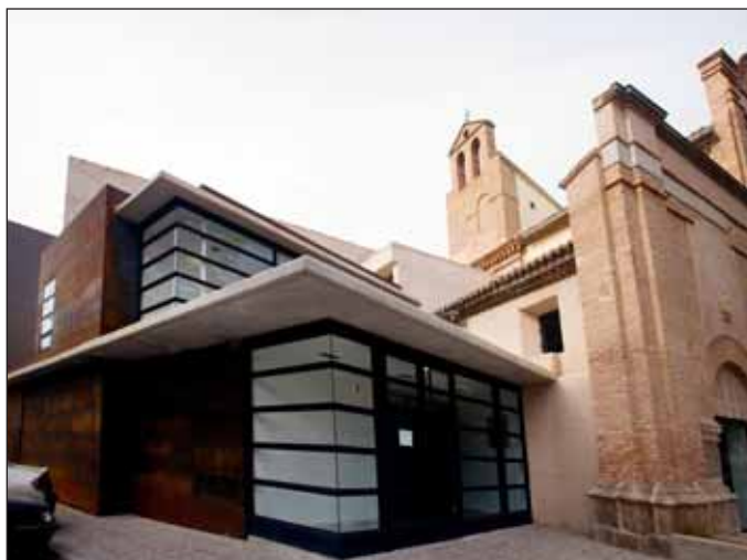
Vista del edificio.
