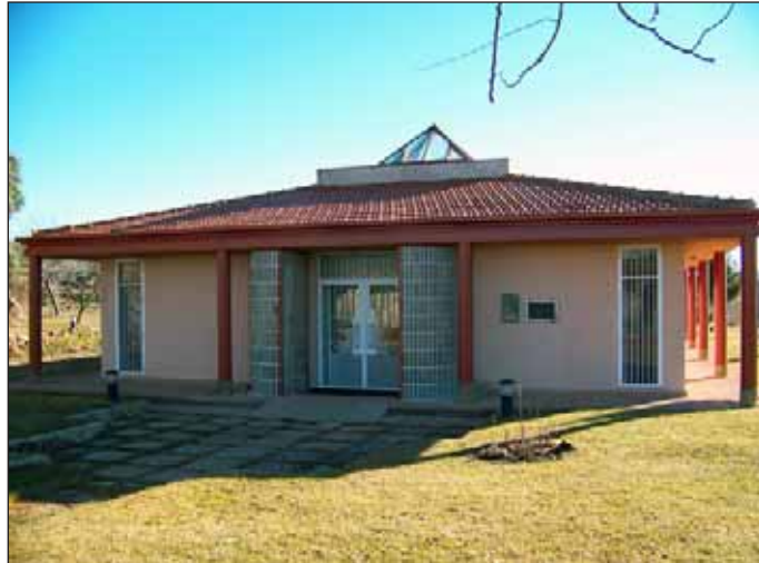
Vista del edificio que alberga el museo.
