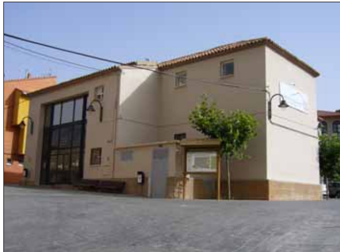
Vista del edificio.
