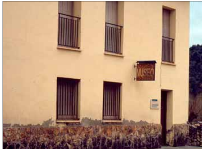
Vista del edificio.
