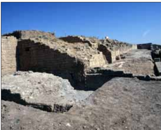
Detalle de la cimentación de la terraza artificial (1ª mitad del s. I d.C.).
