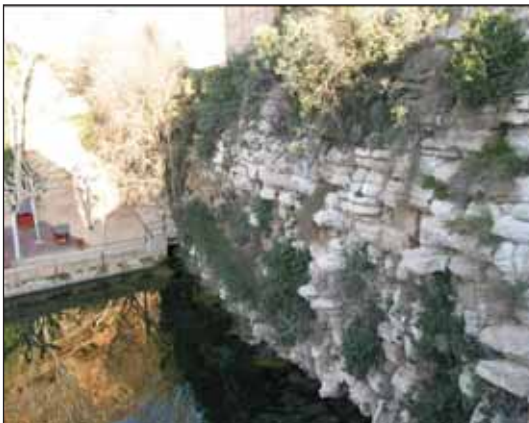
Detalle de los sillares del dique.
