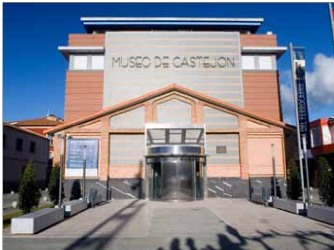
Vista del Edificio.
