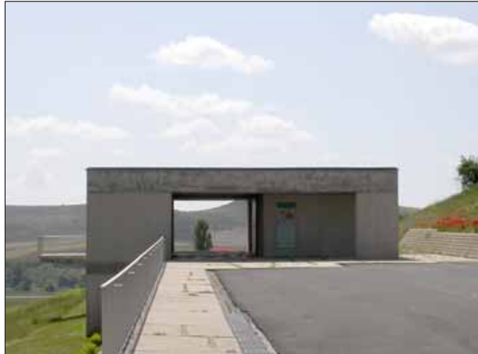
Vista del edificio.
