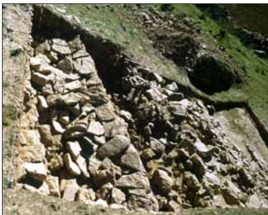
Detalle de la muralla.
